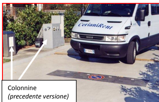
Vasca chiusa dai coperchi (foto 1)
